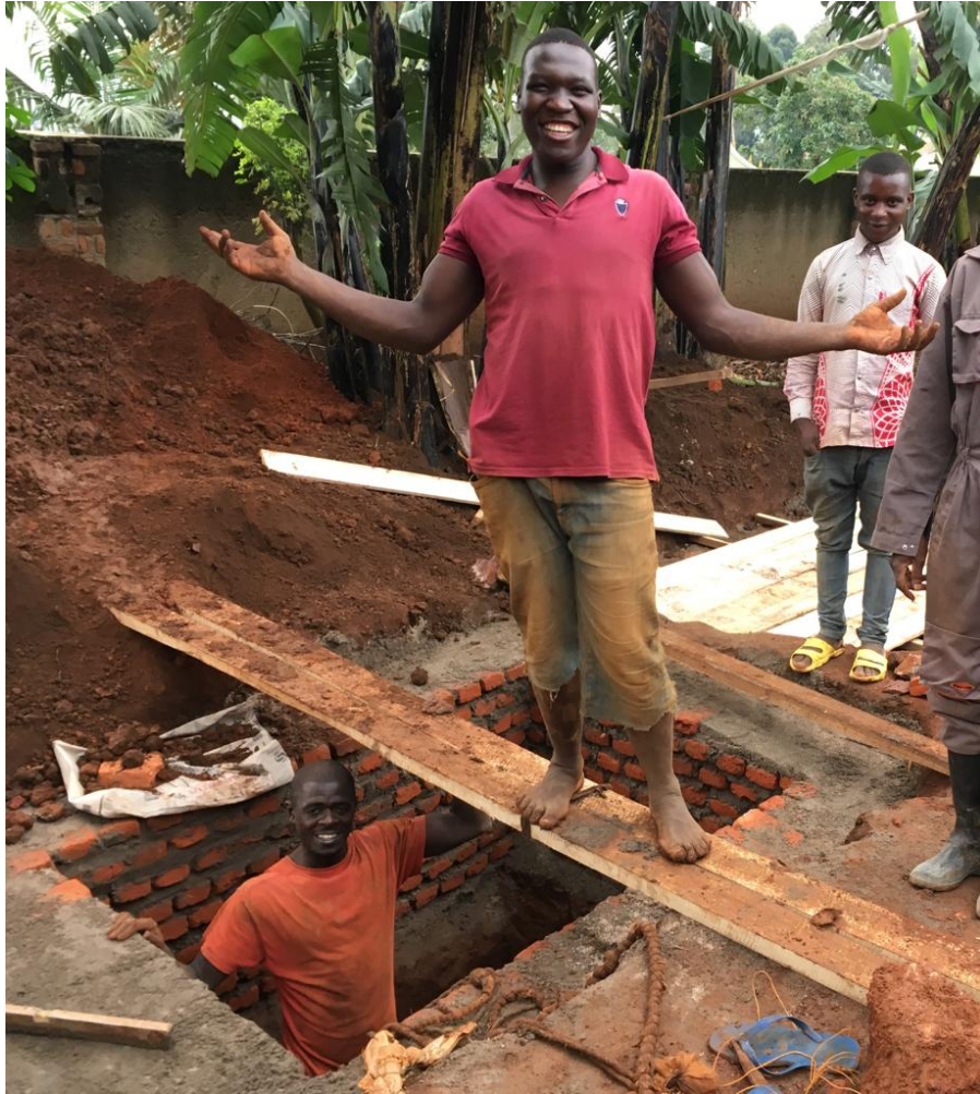
Les puisatiers ont fini de creuser !
