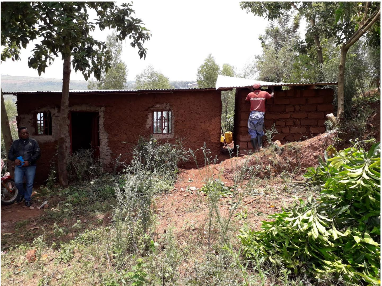
Couverture en tôle des WC
